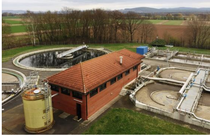
Biologische Reinigung Klärwerk Bachgau
